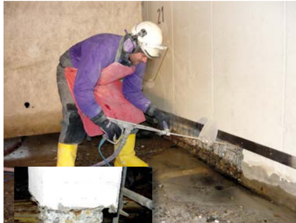
Oben: Alexander Kuhn muss alle Kraft aufwenden, das Wasserstrahlgerät zu halten und die Düse entlang der Arbeitspunkte zu führen (Foto: Böpplebau)
