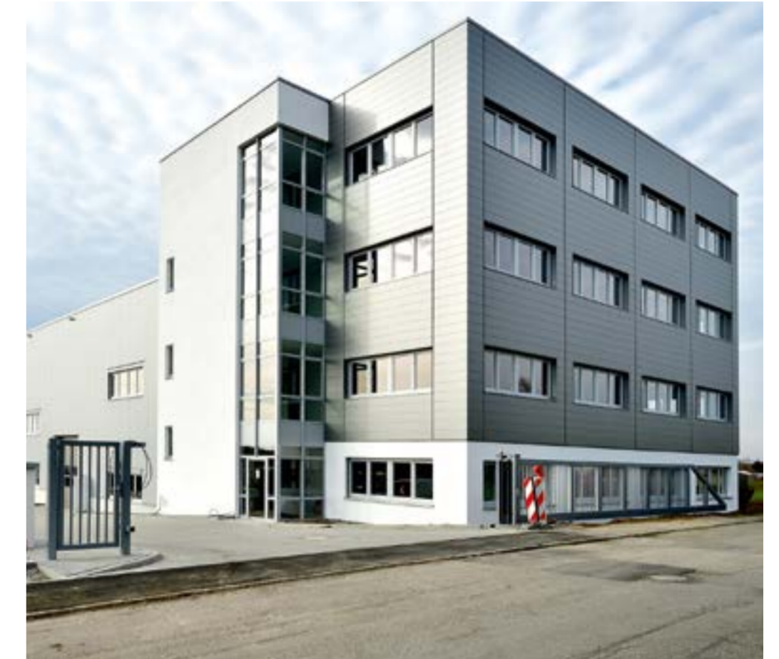
Das Entree des Gebäudes kurz vor der Eröffnung Ende März
