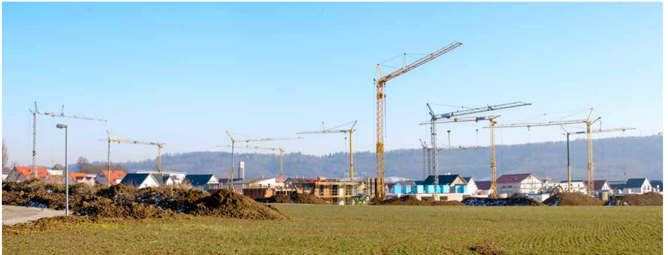
Kräne, nichts als Kräne - und Böpplebau mitten drin. Im Schwäbisch Haller Baugebiet Mittelhöhe stellt Böpple derzeit vier Doppelhaushälften fertig. Für zwei weitere ist demnächst Spatenstich.
