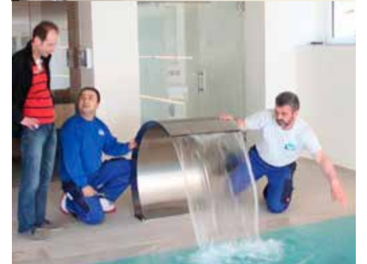
Sadik Cinar und Gökhan Varol in den Katakomben der Haustechnik und bei der Montage der Schwallbrause im Schwimmbad.
