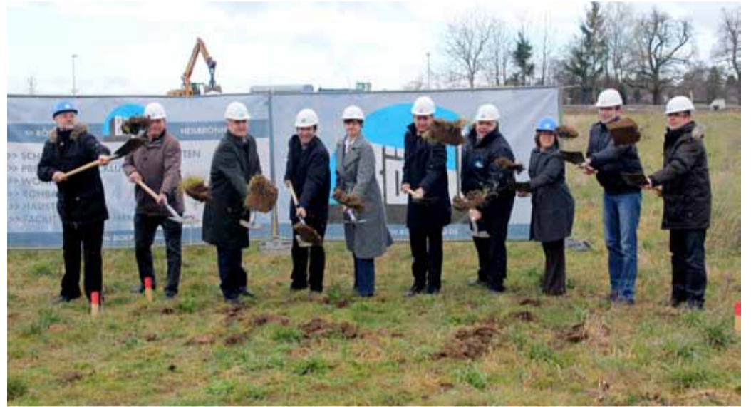
Beispiel einer positiven Entwicklung: Der Netto-Markendiscount schließt in Filderstadt-Hardthausen eine jahrelange Versorgungslücke. Oberbürgermeisterin Gabriele Döning-Poppensieker (5.v.l.) und Alexandros Gkarvanos (Netto-Expansion) in Teamarbeit beim Spatenstich für das Böpple-Projekt.
