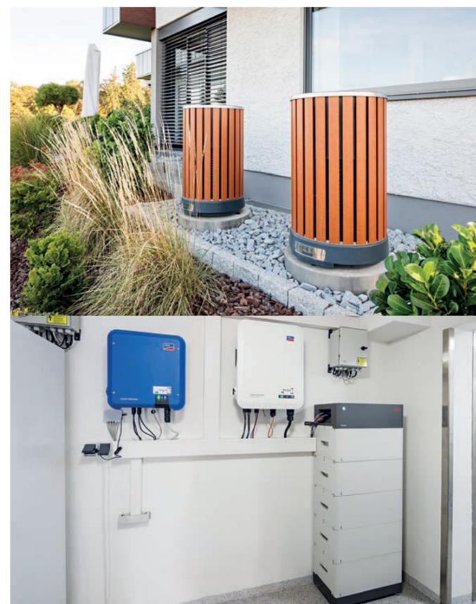
Wärmepumpe von der Firma Remco (oben) sowie Wechselrichter der PV-Anlage und Batteriespeicher (unten)
